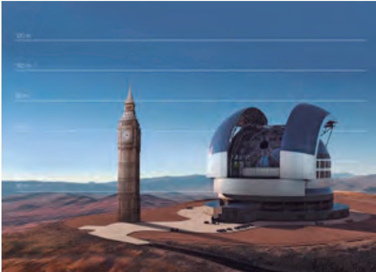
Figura 1. Un ejemplo de gran ciencia: recreación del gran telescopio ELT. Con un espejo segmentado de 39 metros de diámetro, está siendo construido por un consorcio de 16 países europeos en el que participa España, y Chile como anfitrión, en el desierto de Atacama. | ESO.
