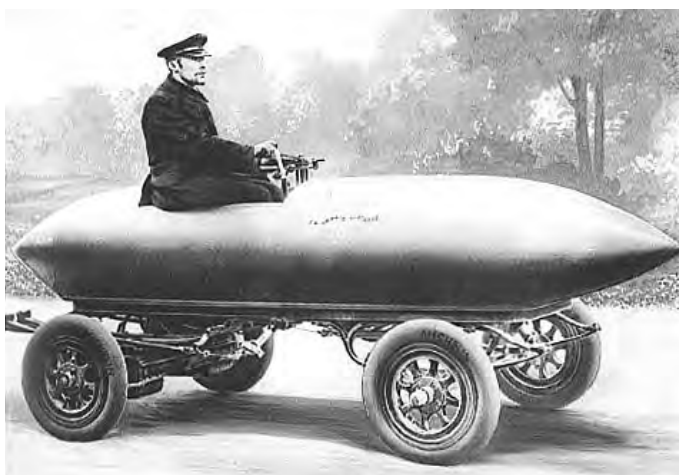
Figura 3. Coche eléctrico belga “Jamais Contente” que en 1899 alcanzó 104 km/h.
